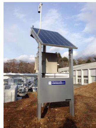
Fig.2 システム外観
